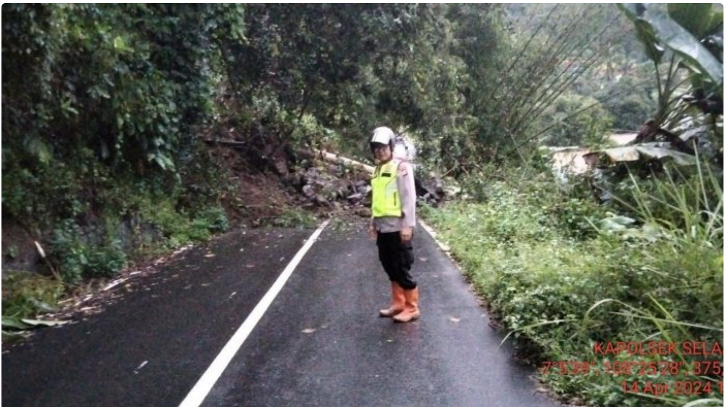
Akses jalan dari Selajambe menuju Darma kembali tertutup Longsor
